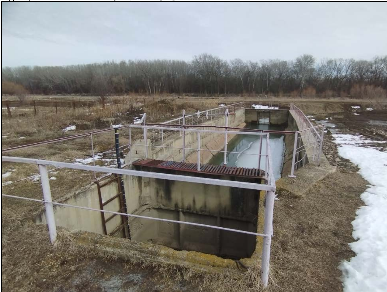
Рисунок А.1 – ЦС ХВС с. Вольное, п. Дивный, п. Заречный, с. Марьино: приемный бассейн
