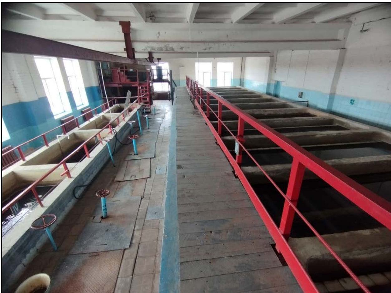
Рисунок А.3 – ЦС ХВС с. Вольное, п. Дивный, п. Заречный, с. Марьино: блок осветлителей и скорых фильтров
